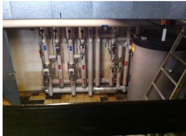
Nebst einer Kapazitätserweiterung bei der Holzsnitzelheizung des Wärmeverbunds der Einwohnergemeinde Bretzwil bedingte dieses Projekt eine 122 m lange Anschlussleitung sowie die Installation der entsprechenden technischen Einrichtungen innerhalb des Baumgartenschulhauses. Auf die ursprünglich entlang der Bühne geplante Sickerleitung wurde verzichtet. Darüber hinaus ist die Zuleitung entgegen den ersten Planungen auf der Höhe des Parkplatzes seitlich ins Baumgartenschulhaus eingeführt worden.
