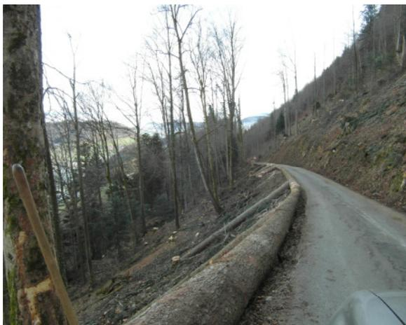
Bei dannzumal optimalen Bedingungen ist die „schlechtere“ Qualität der gefällten Bäume für das Erstellen der Strassenabweiser benutzt worden. Mit dem Forstschlepper wurden die Stämme entlang der Strasse gelegt. Einzelne Stämme mussten mit einem Querstamm bis zu 10 m talwärts gesichert werden. An den Verbindungsstellen sind die Stämme zusätzlich mit bis zu einem Meter langen Nägeln oder mit Bundhaken befestigt worden. Ausgeführt wurden diese Arbeiten von der Forstequipe des Forstreviers Hohwacht.
